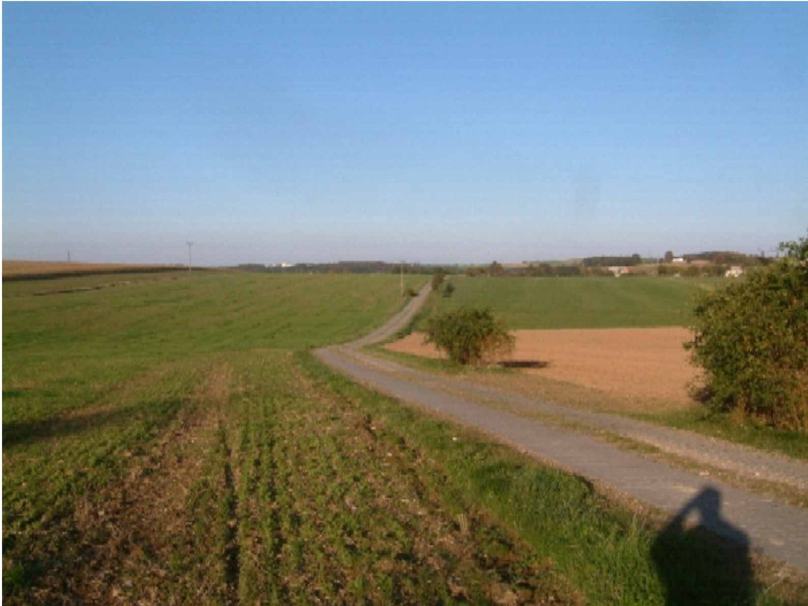
Wegebaumaßnahme der TG Callenberg Nord in der Gemarkung Langenchursdorf: Ausbau auf alter Trassenführung unter Berücksichtigung des Geländes
