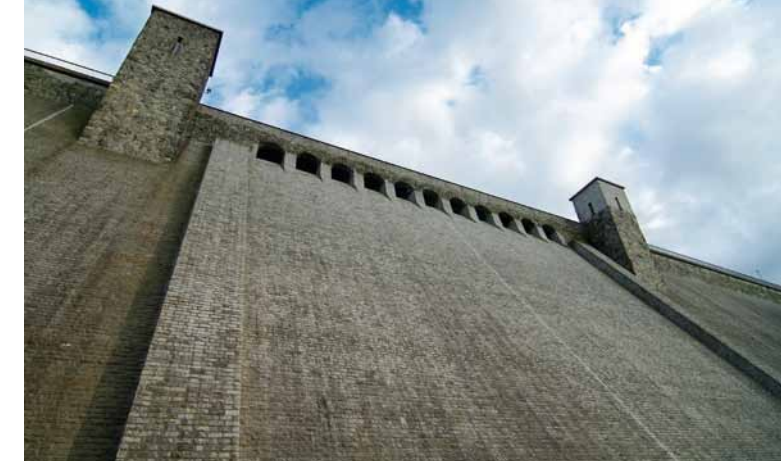
Talsperre Lehmühle – Hochwasserentlastungsanlage
