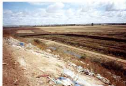
Neuer Meliorationsgraben, der den Zustrom von Niederschlags- und Drainagewasser zur Deponie verringert
