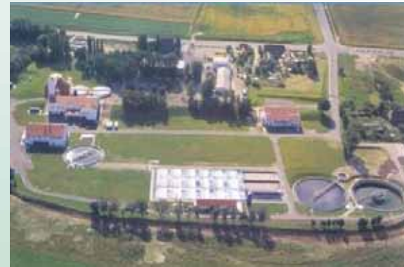
Kläranlage, Fa. HST
