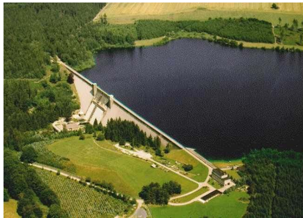
Abb. 2: Schwergewichtsstaumauer mit Dammanschluss der TS Lehnmühle
