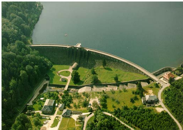
Abb. 1: Schwergewichtsstaumauer der Talsperre Klingenberg
