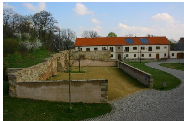
Ehemalige Grundmauern umrahmen den Parkplatz (Foto: LfULG, Vogel)
