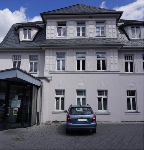
Arbeiten und Wohnen unter einem Dach – Schaffung einer Arztpraxis und zweier Wohnungen in einer ortsbildprägenden Villa in Oederan 2018 Foto: Regionalmanagement Erzgebirgsregion Flöha- und Zschopautal
